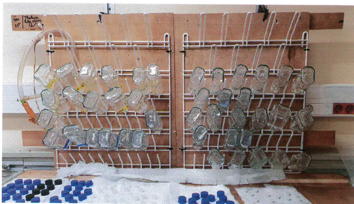
(Installation des deux postes de salinités - laboratoire propre – bâbord – pont C)
